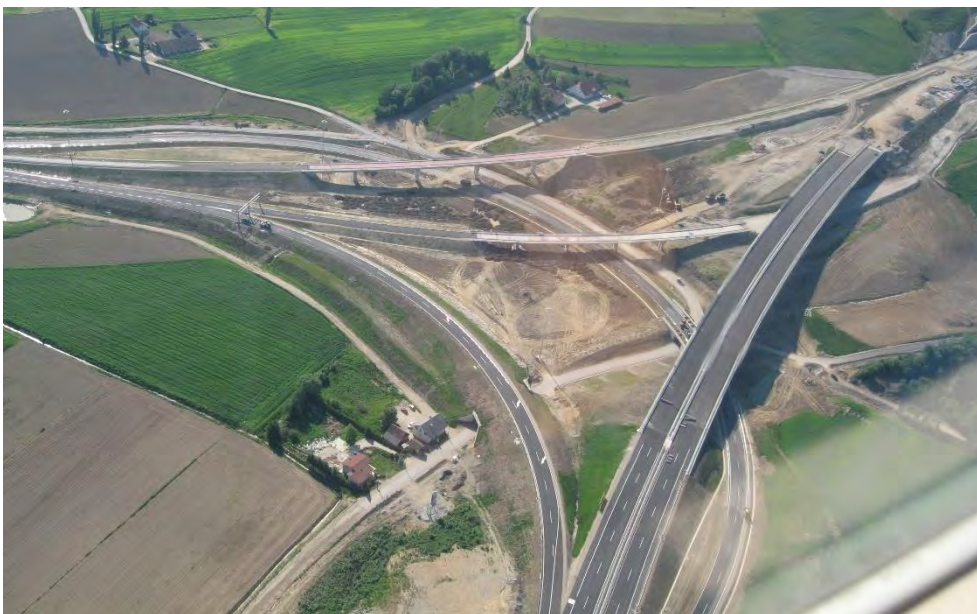
Slika 10: Gradnja razcepa Dragučova
