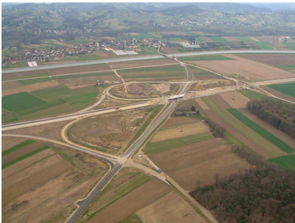
Slika 7: Gradnja priključka Zrkovci
