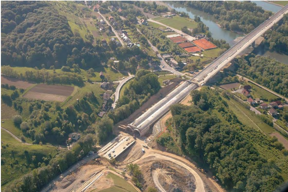
Slika 8: Gradnja pokritega vkopa Malečnik
