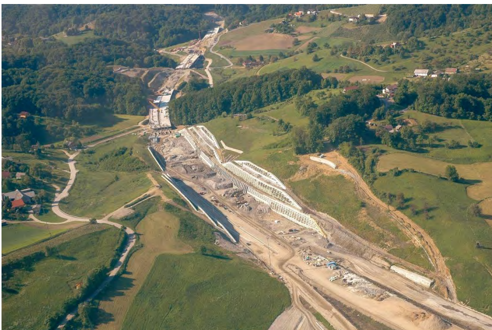
Slika 9: Gradnja odseka Zrkovska– Pesnica
