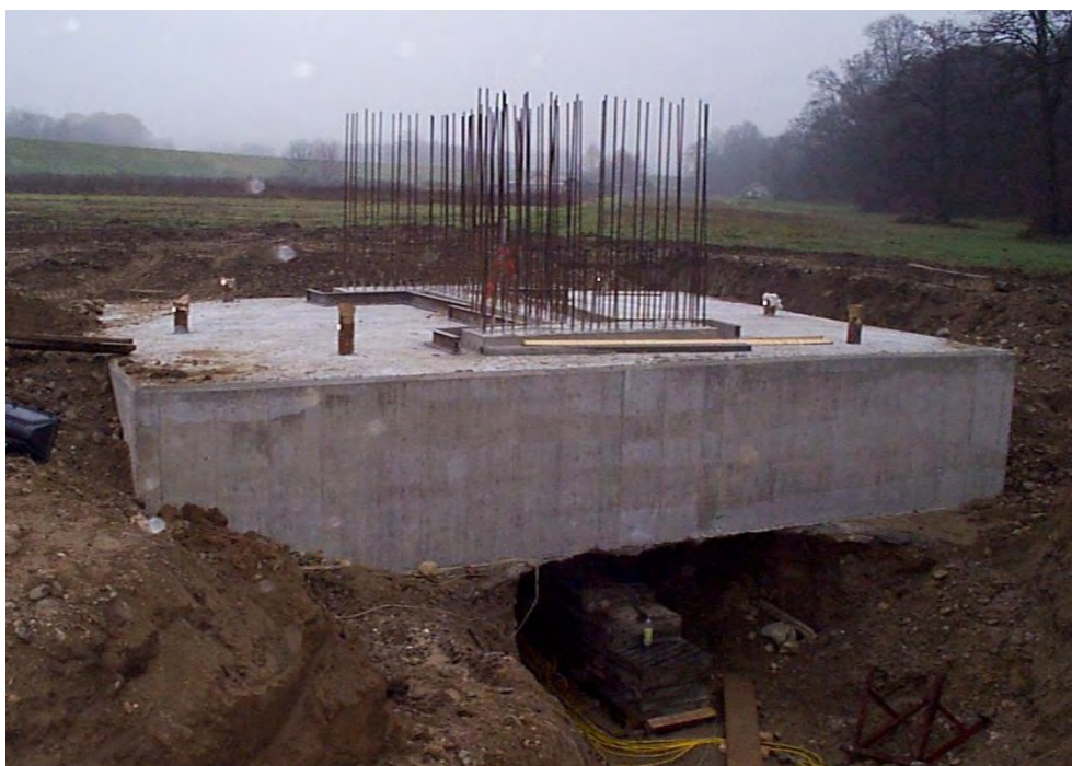
Slika 7: Obremenitev pilota s pilotno blazino v podpori 3D, most čez Dravo (Ksenija Štern).
