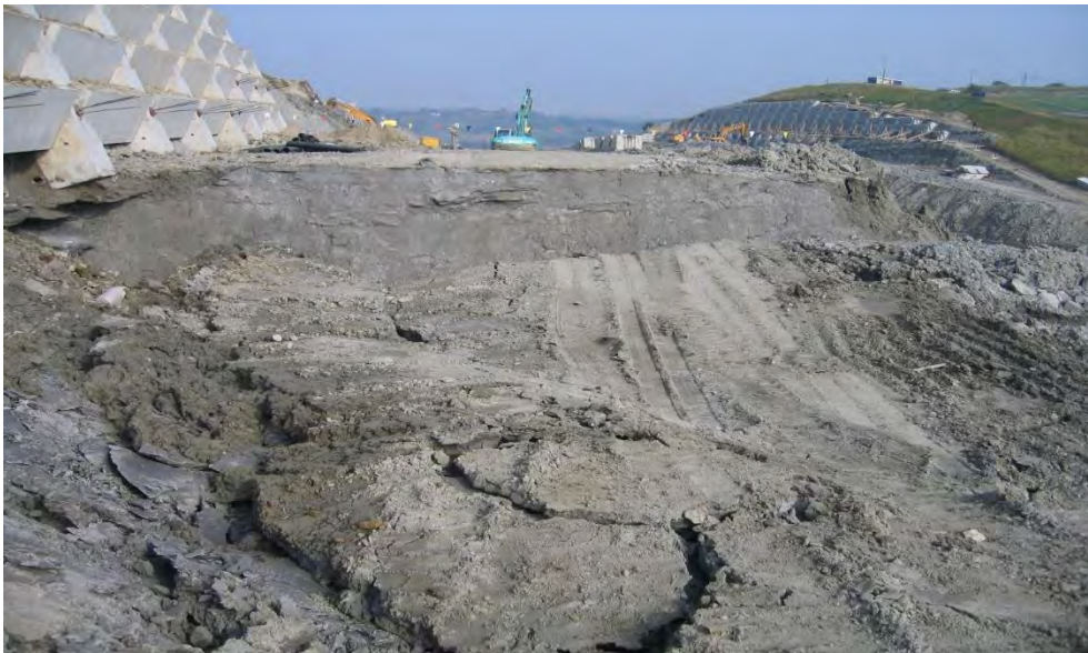
Slika 17: Podor laporja na srednji bermi v P587 in OZ-07 v ozadju. (K. Štern)
