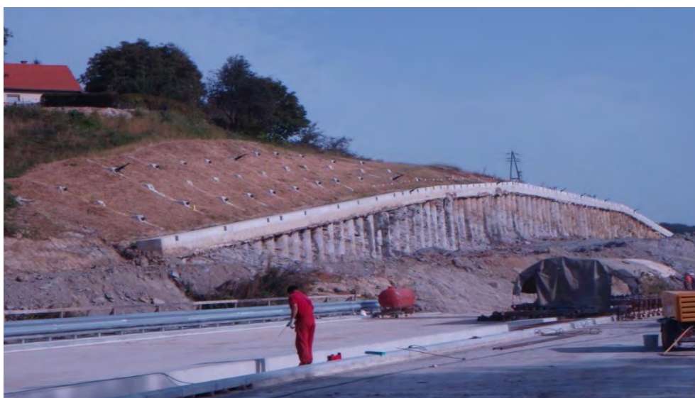
Slika 15: Dodatni ukrepi na brežini v zaledju OZ-04. (K. Štern)
