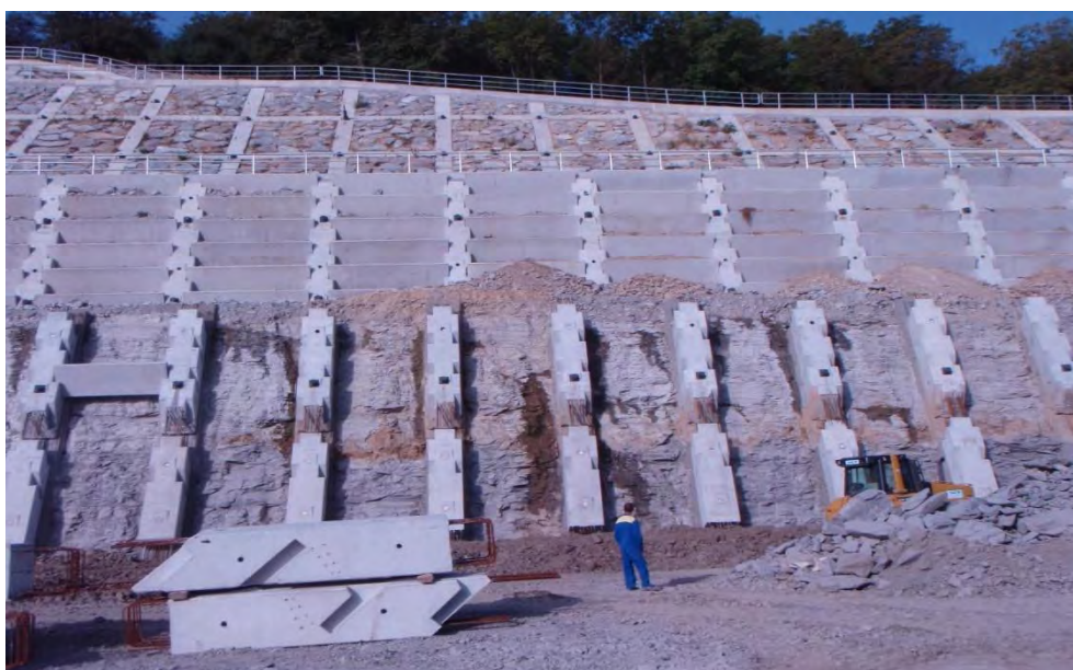
Slika 14: Gradnja slopov na OZ-01. (K. Štern)
