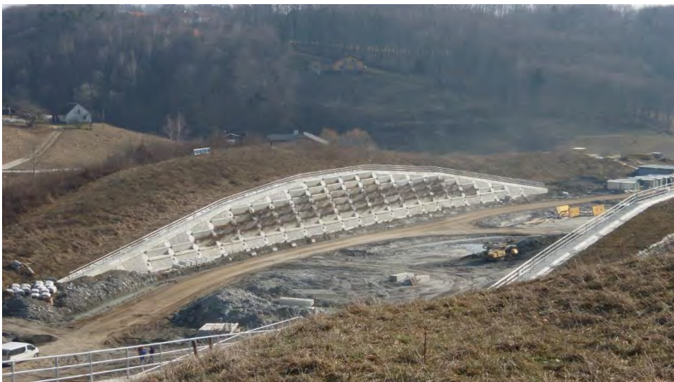
Slika 16: Pogled na oporni zid OZ-06. (K. Štern)
