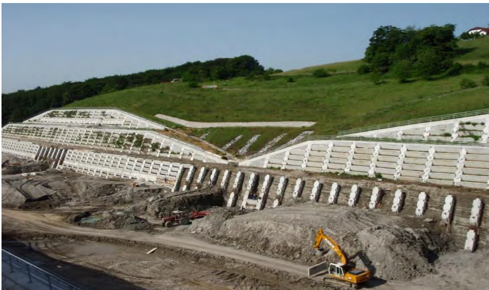
Slika 18: Pogled na oporni zid OZ-05, proti koncu gradnje. (K. Štern)
