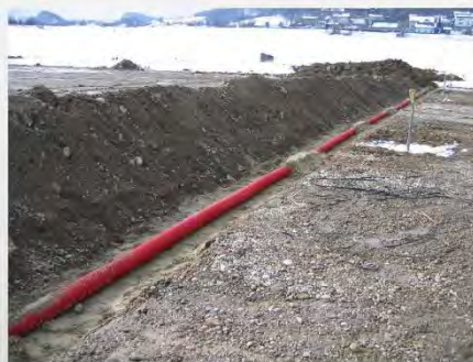
Slika 13: Vgradnja horizontalnega inklinometra in prikaz rezultatov meritev. K. Štern)
