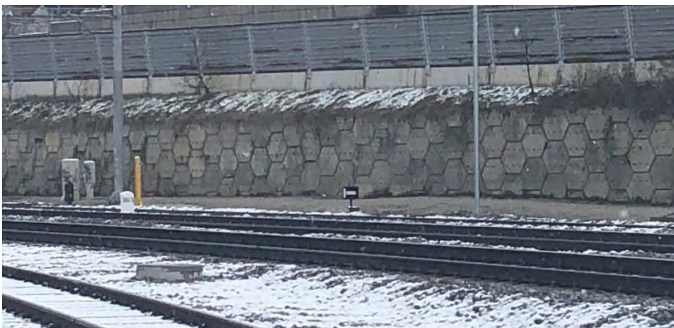
Slika 1: Nasip iz armirane zemljine na HC skozi Maribor v Košakah. (K. Štern)
