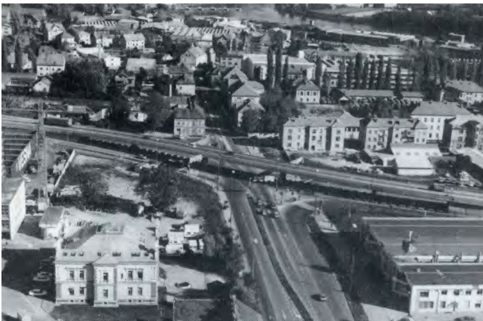
Slika 12: Nadvoz v Melju, zgrajen v sklopu 3. etape hitre ceste skozi Maribor [2].
