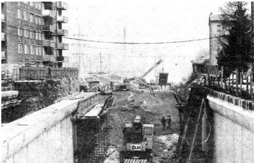
Slika 6: Gradnja Pobreške galerije tik ob stanovanjskih blokih [2].
