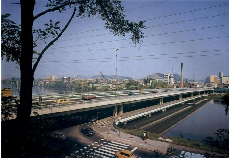
Slika: 4 Dvoetažni most v Mariboru v 80. letih prejšnjega stoletja [4].
