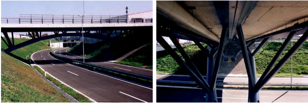
Slika 20: Atraktivna konstrukcijska zasnova nadvoza Vodovodne ulice čez mariborsko hitro cesto. Nadvoz je bil zasnovan kot sovprežna armiranobetonska konstrukcija s podpornim jeklenim ločnim paličjem [7].
