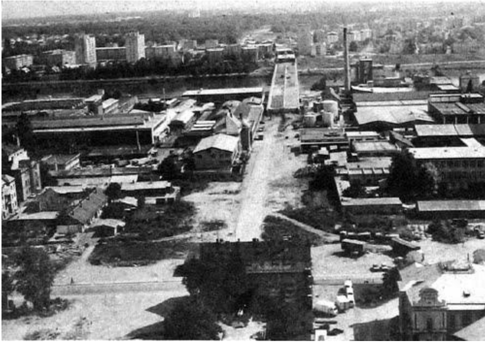
Slika 2: Gradnja dvoetažnega mostu, pogled iz meljske strani [2].
