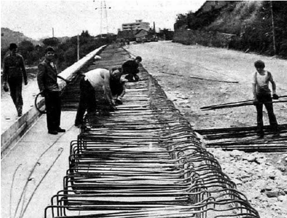
Slika 1: Gradnja podpornega zidu iz armirane zemljine na Pobreški cesti [2].
