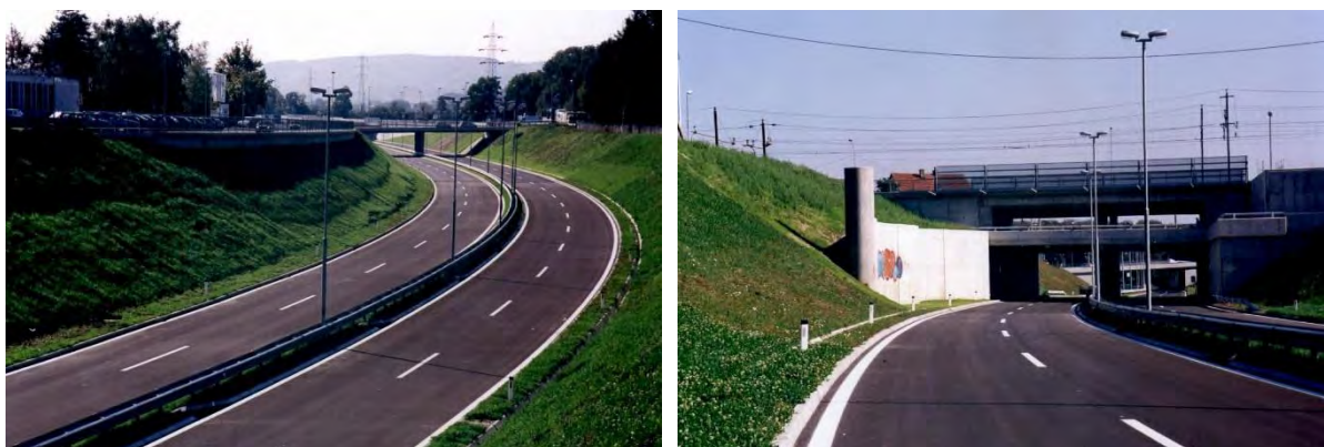
Slika 18: Z izgradnjo zadnje, 4. etape, so po 22 letih dokončali štiripasovno hitro cesto skozi Maribor v smeri sever–jug [7].
