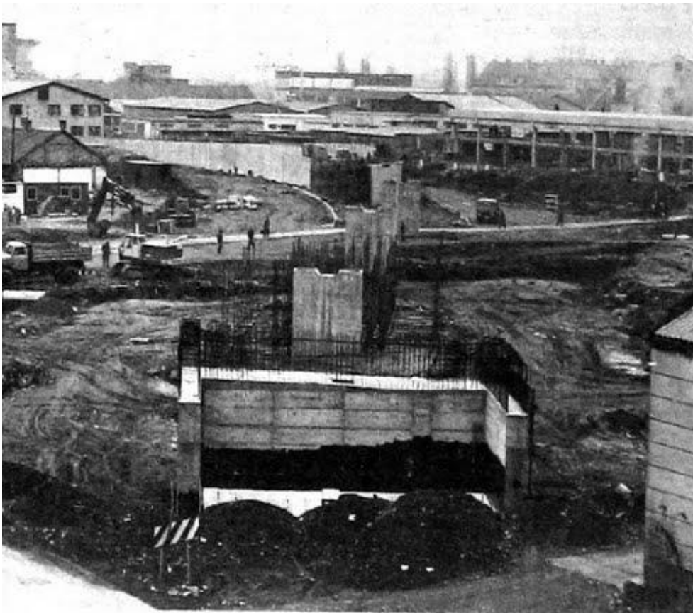
Slika 11: Gradnja podpornih stebrov nadvoza v industrijski coni Melja [2].
