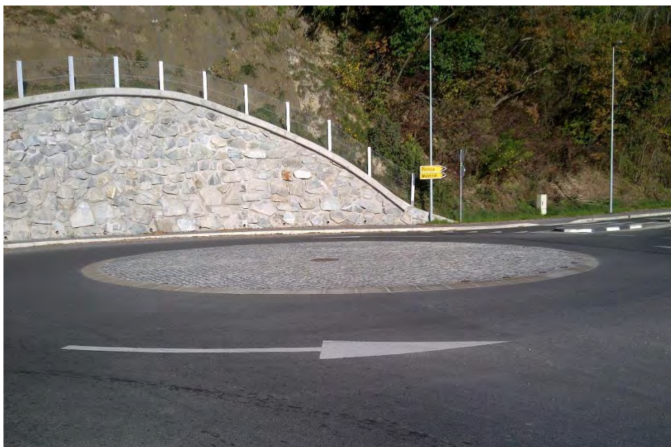
Slika 3: Mini krožno križišče Meljske ceste in Malečniškega mosta
