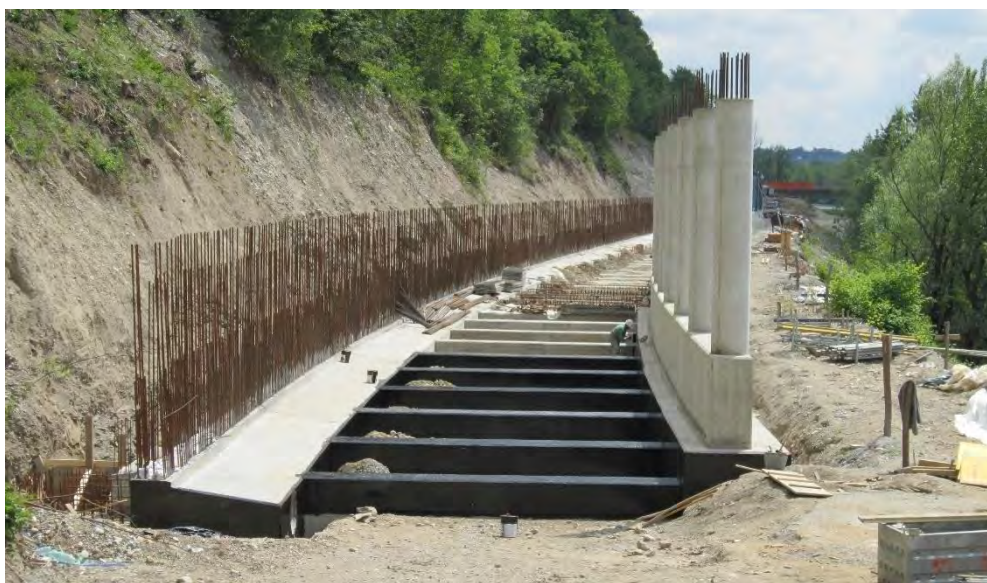
Slika 1: Gradnja armiranobetonske galerije
