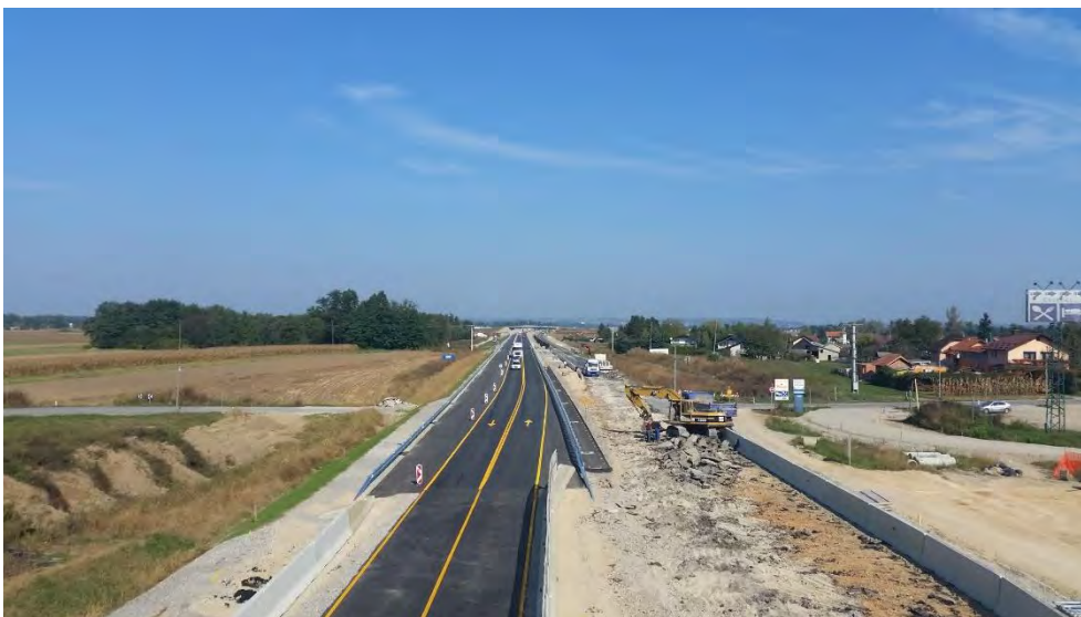
Slika 6: Gradnja odseka Draženci – Gruškovje
