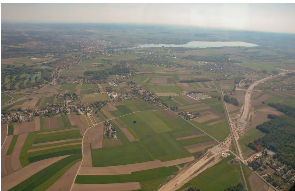
Slika 2: Gradnja avtoceste pri Dražencih z viaduktom preko železnice Pragersko – Ptuj
