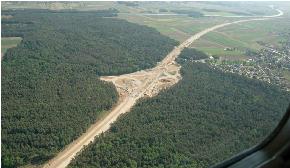
Slika 3: Gradnja priključka Marjeta
