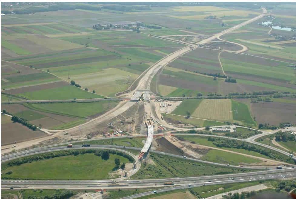
Slika 1: Gradnja razširitve razcepa Slivnica in priključka Letališče
