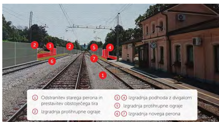
Slika 2: Opis del v sklopu Nadgradnje železniške proge Maribor–Šentilj
