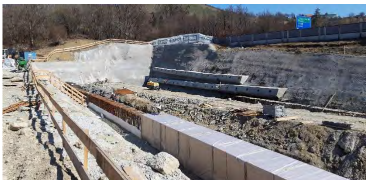
Slika 13: Gradnja predora Pekel
