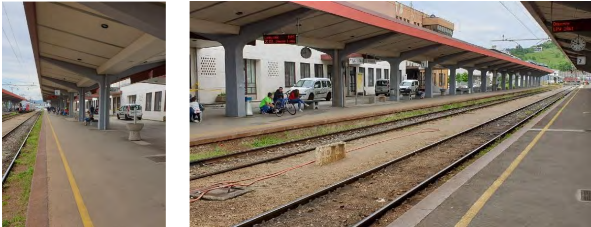
Slika 8: Železniška postaja Maribor pred izvedbo
