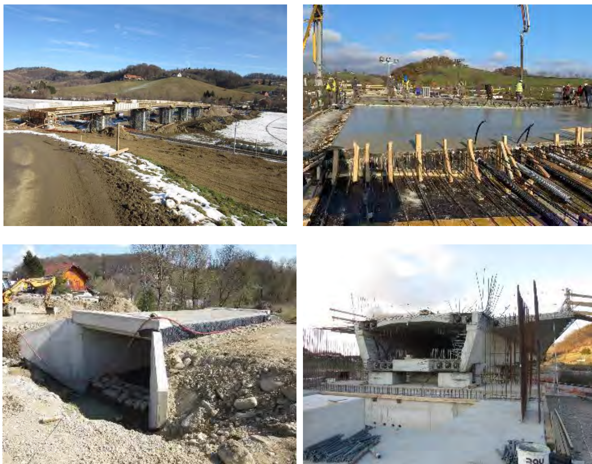
Slika 16: Gradnja izvennivojskih križanj na odseku Pesnica-Šentilj-državna meja
