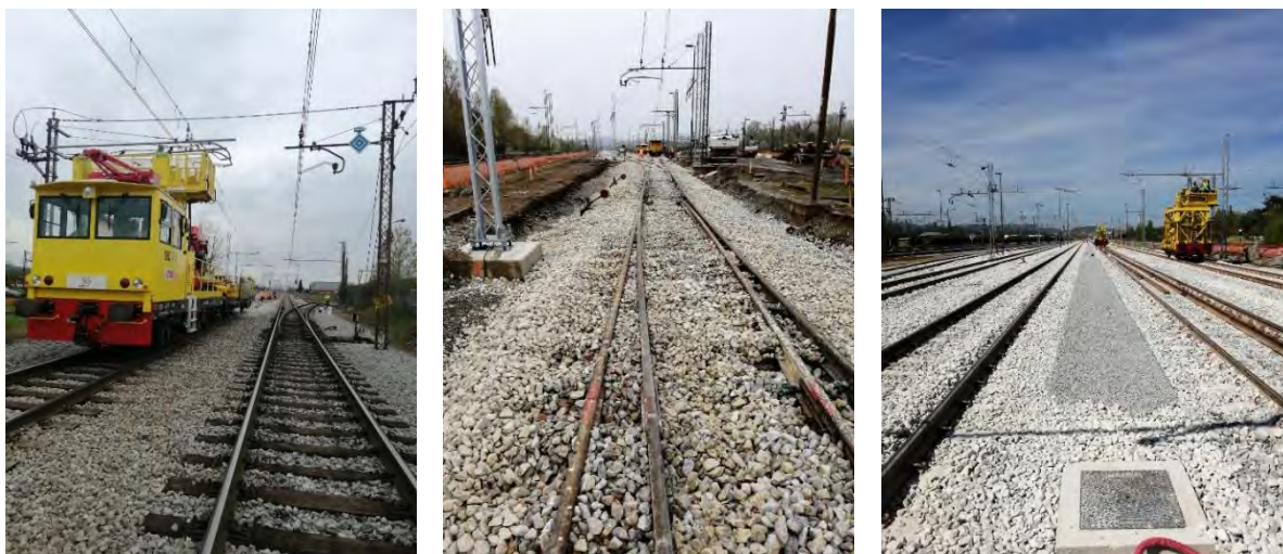
Slika 6: Železniška postaja Maribor–Tezno med izvedbo
