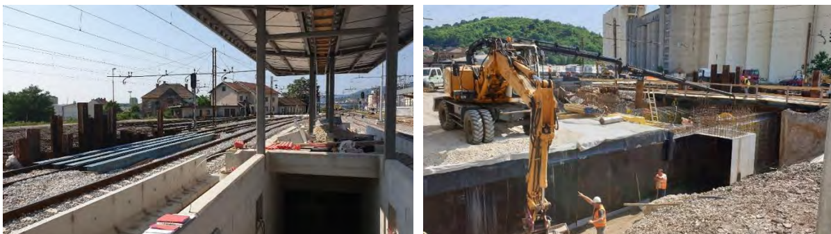
Slika 9: Železniška postaja Maribor med izvedbo
