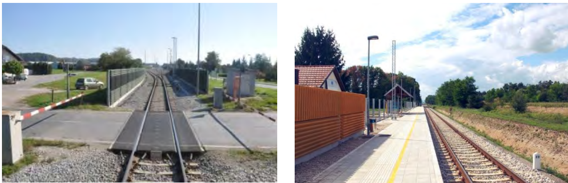
Slika 11: Izvedba nivojskega prehoda ter Izvedba protihrupne zaščite [4]
