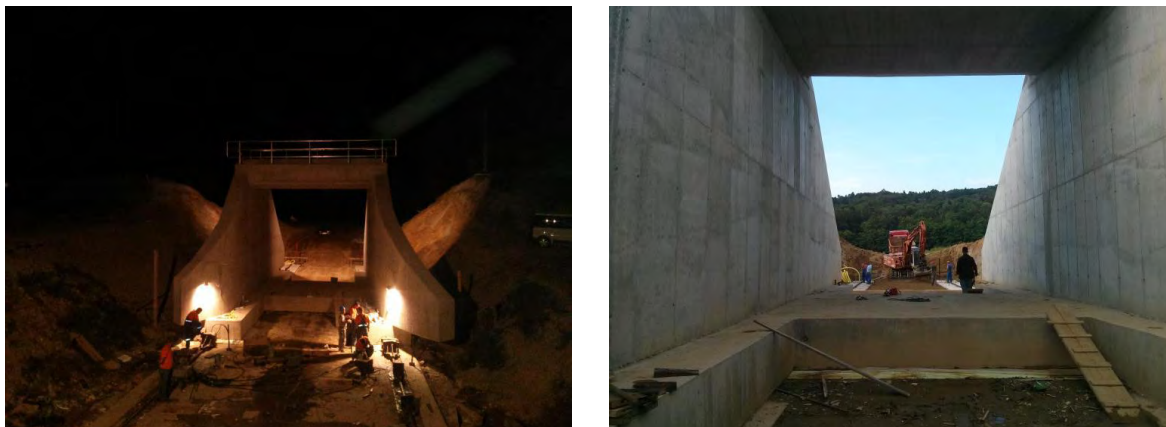
Slika 7: Izvedba podvoza Kamenščak [3]
