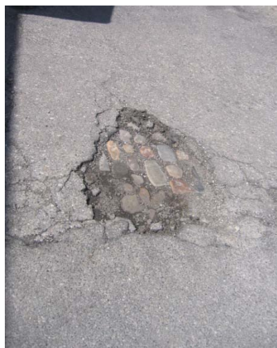
Slika 7: razkritje pod asfaltom
