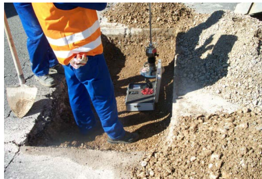
Slika 2: Primer izvedbe meritev z dinamično ploščo za ugotovitev nosilnosti podlage
