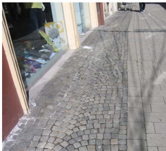
Slika 9: Polaganje tonalitnih kock v betonsko podlago
