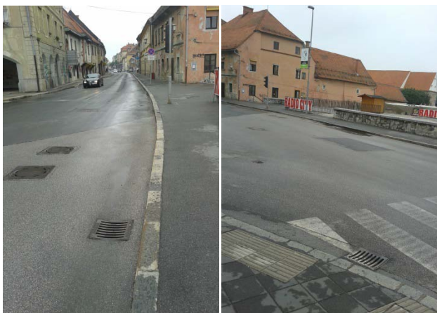
Slika 7: Požiralniki ob robniku pločnika Koroške ceste pri tržnici v Mariboru
