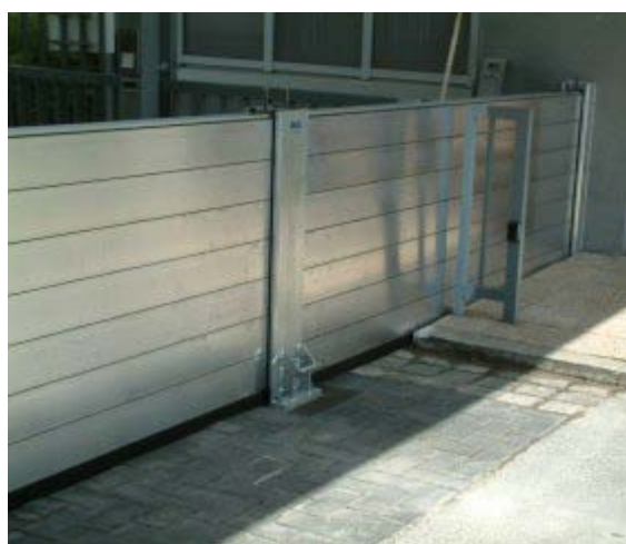
Slika 6: Savinja – odsek1: Varovanje v območju Polulskega mostu in mobilne zagatne stene
