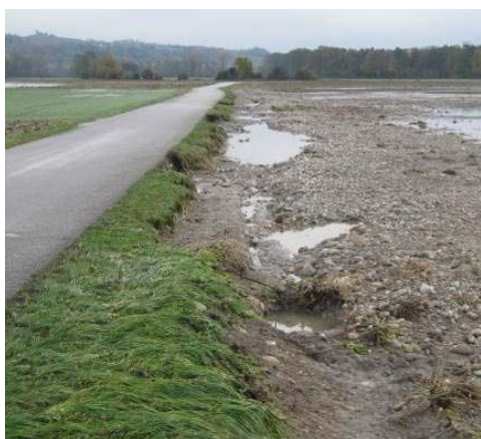
Slika 2: Prelivanje cestišča pod Vurbergom in poškodbe na dolvodni strani ceste (foto: Agata Suhadolnik)
