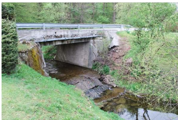
Slika 8: Neustrezna premostitev tako glede zožitve prereza kot umestitve na nivoletu na Grajeni (foto: Agata Suhadolnik)
