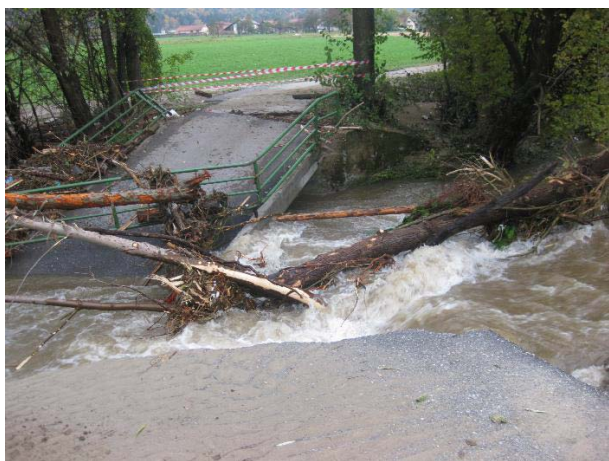
Slika 1: Preizkus odpornosti mostu na procese v vodotoku ob pojavu visoke vode (foto: M. Kogoj)
