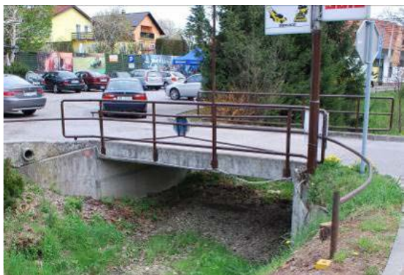
Slika 9: Premostitev, ki zožuje pretočni profil na Grajeni (foto: Agata Suhadolnik)
