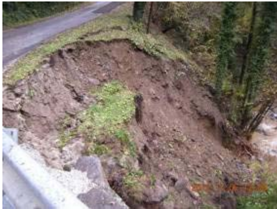
Slika 12: Spodjedanje mostu in dovoza (foto: Zdenko Zorič)
