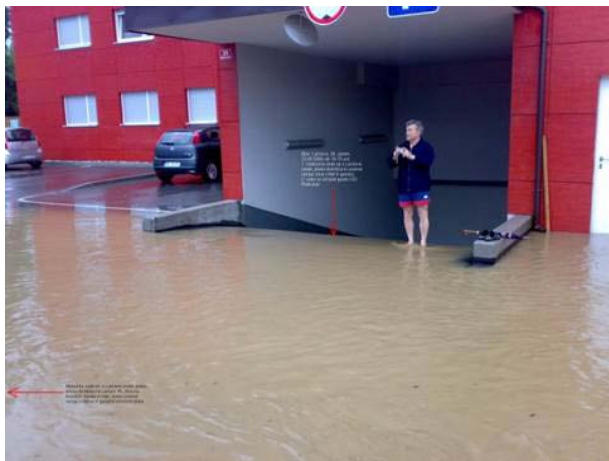
Slika 15: Poplave na novozgrajenem odseku Lackove ceste v Mariboru
