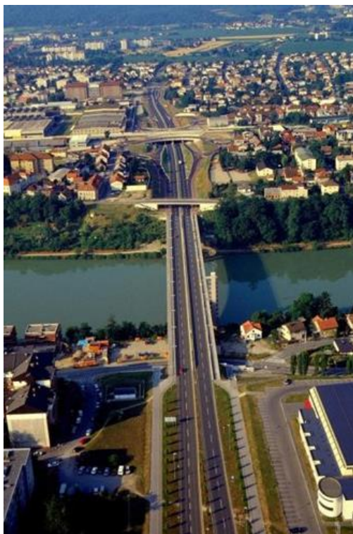
Slika 9: I. etapa Zahodne obvoznice po izgradnji.
