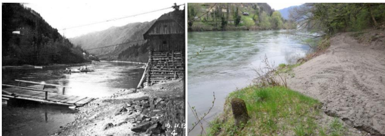
Slika 31: levo - brodska vstopna rampa, hiška za napenjanje nosilne vrvi in dostopna pot s kamnito škarpo in tlakovana kamnita rampa proti reki (posneto leta 1913; vir; Arhiv Maribor) desno - fotografija primarne lokacije broda danes, vidna dostopna pot in varovalni kamnit stebriče (foto Simerl)
