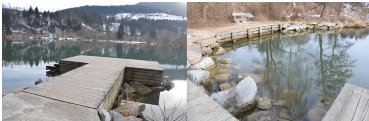
Slika 13: Pomol – valobran v Dravogradu, nemogoče direktno pristati, ker se plovilo poškoduje – razbije (foto Simerl)
