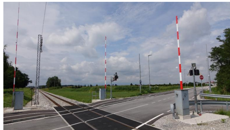
Na novo urejen železniški prehod, zavarovan z zapornicami
